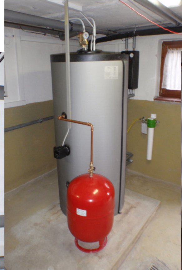
Höcker Hygienespeicher (Schichtenspeicher) optimale Wärmespeicherung
