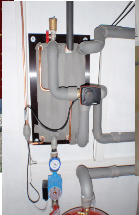
Höcker Wärmetauscher- Kaskade optimale Wärmeübergabe
